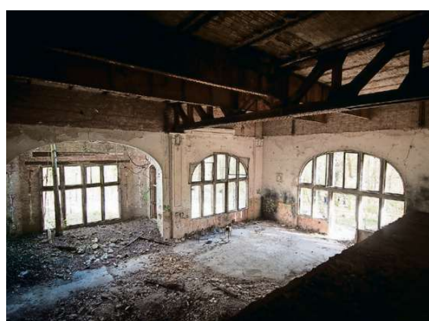
Die Gebäude wären nur noch Steinhaufen, wenn sie nicht durch Stahlträger zusammengehalten würden.
